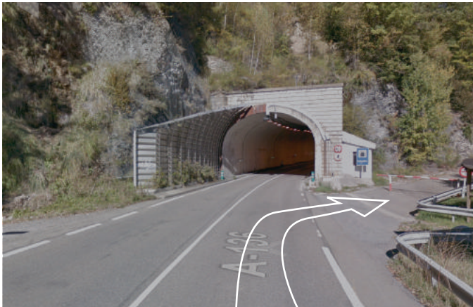
A-136 direccion Francia hasta el Tunel. Giro a la derecha por carretera auxiliar de uso ciclista alternativo al tunel
