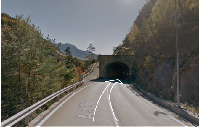
A-136 hasta localidad de Escarrilla por túnel.
